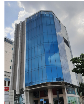
Mặt dựng nhôm kính Cộng Hòa
