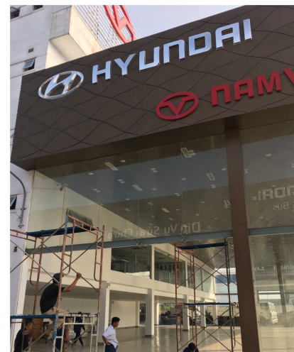
Mặt dựng nhôm kính Quận 7
